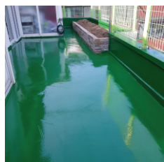
<옥상 방수 공사>
