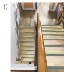
1) <실내계단 보수 공사>
